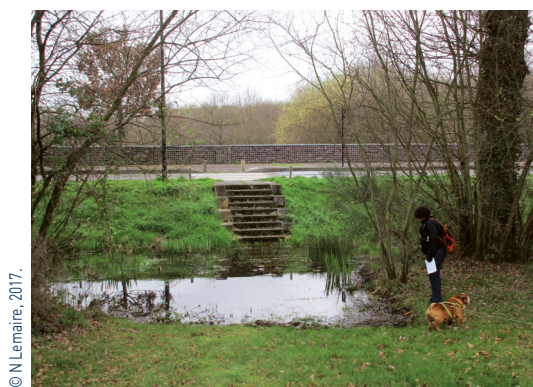
Cet aménagement intègre des noues qui gèrent l'infiltration des eaux pluviales dans le sol. Ici, la "solution d'ingénierie basée sur la nature" est intégrée à un projet paysager et contribue à enrichir le cadre de vie.
