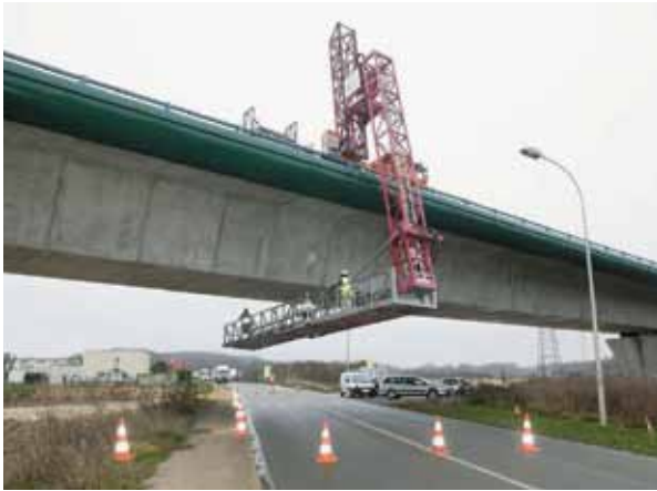
Figure 4 - Inspection détaillée avec passerelle de visite (Photo : Sétra)
