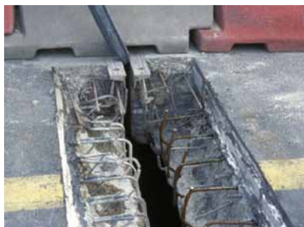
Figure 8 - Changement d'un joint de chaussée (Photo : Sétra)
