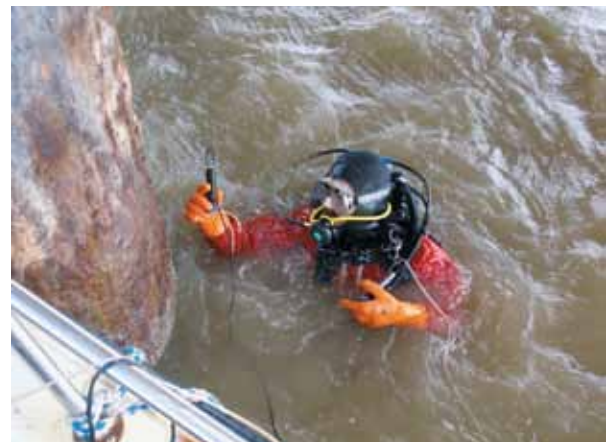
Figure 5 - Inspection sub-aquatique (Photo : CETE Île-de-France)
