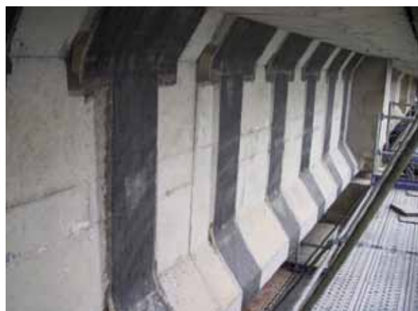
Figure 9 - Matériau composite collé sur une poutre (Photo : Sétra)
