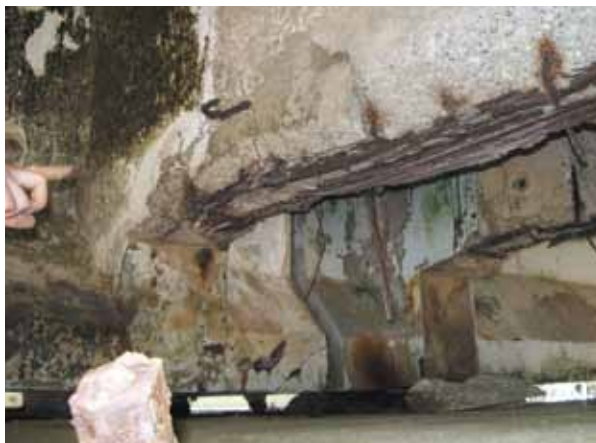
Figure 3 - Dégradation du béton armé (Photos : Sétra)
