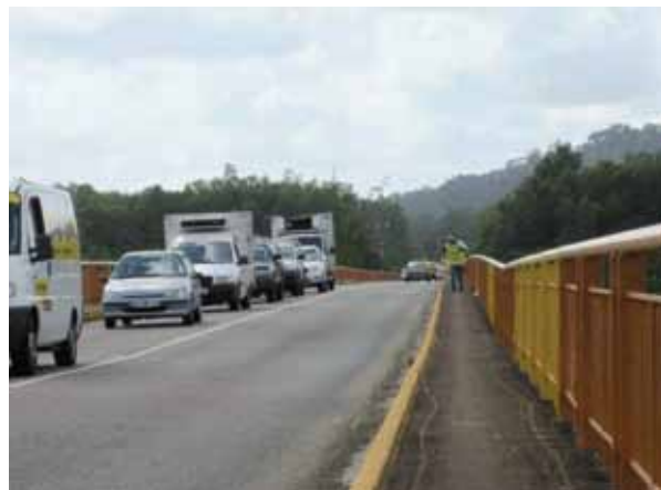
Figure 2 - Déformations significatives du garde-corps (Photos : Sétra, DEAL 973)
