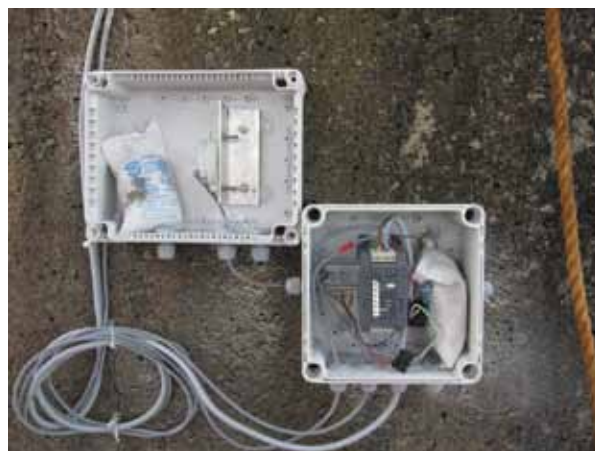
Figure 6 - Suivi des mouvements d'une pile par inclinomètre (Photo : LRPC de Bordeaux)
