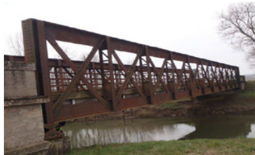
1954 – Aciers doux, rivets, hourdis béton armé
