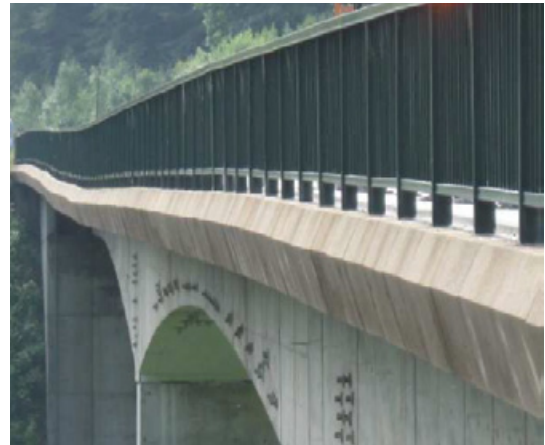
1972 – déformée liée à la non-prise en compte du fluage et du gradient thermique
