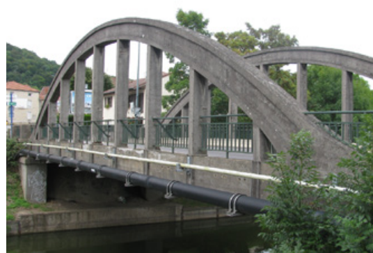
1953 - suspentes et pièces de pont plus épaisses
