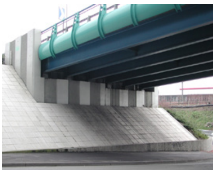
Exemple de culées avec talus ou perré
