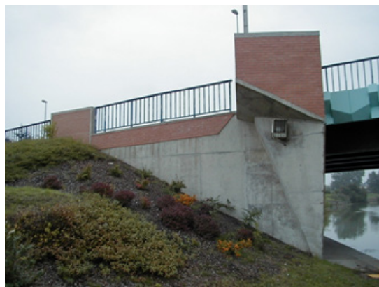
Exemples de culées avec mur de front
