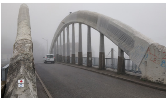
1926 – suspentes et pièces de pont fines
