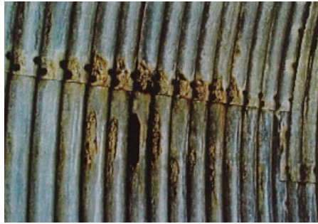
Corrosion localisée
