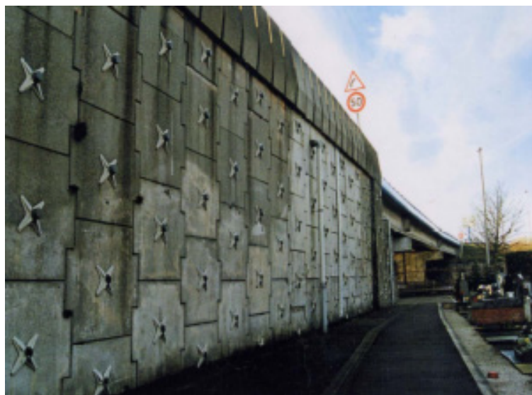
Réparation d'un mur par clouage
