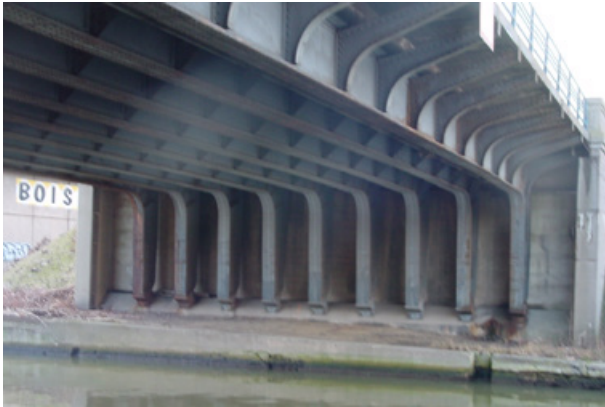
1946 – bacs en acier coffrant le béton
