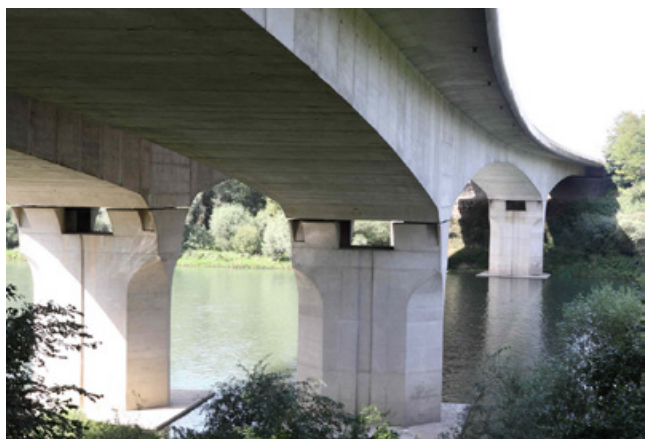
1977 – pont caisson en béton précontraint
