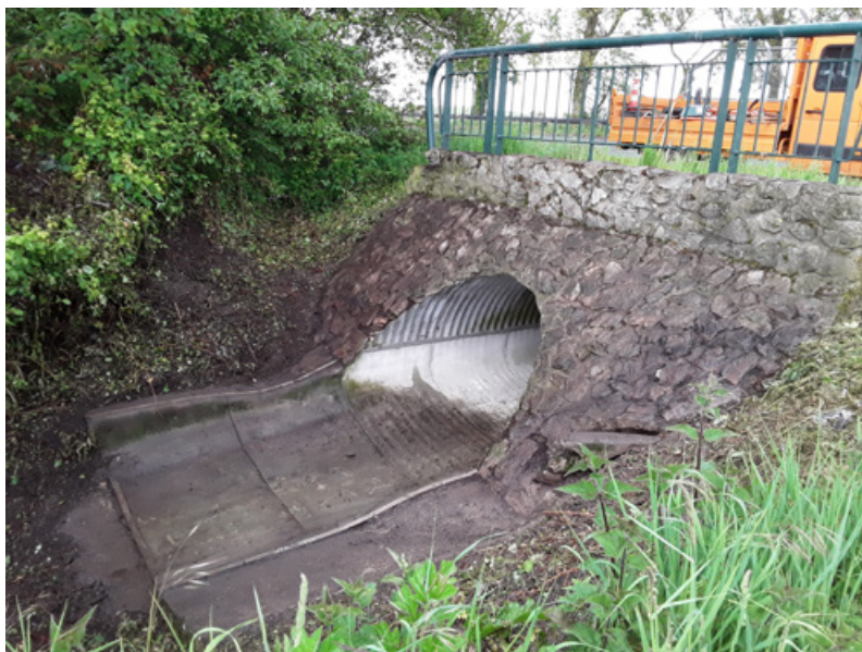
Travaux de dévégétalisation
