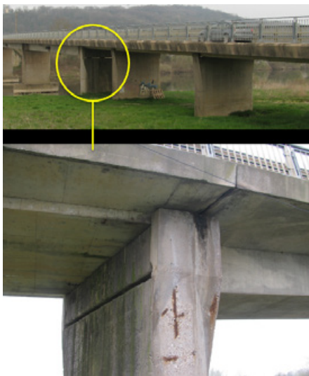
Exemple de pile-culées
