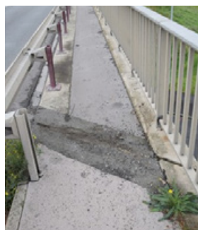
Glissière de sécurité
