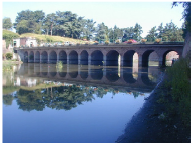
Pont en maçonnerie à arches multiples
