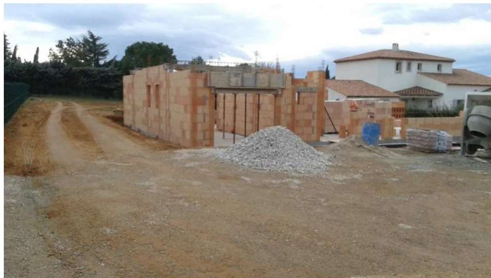
Niveau de la maison plus bas que le terrain alentour – Photo Cerema
