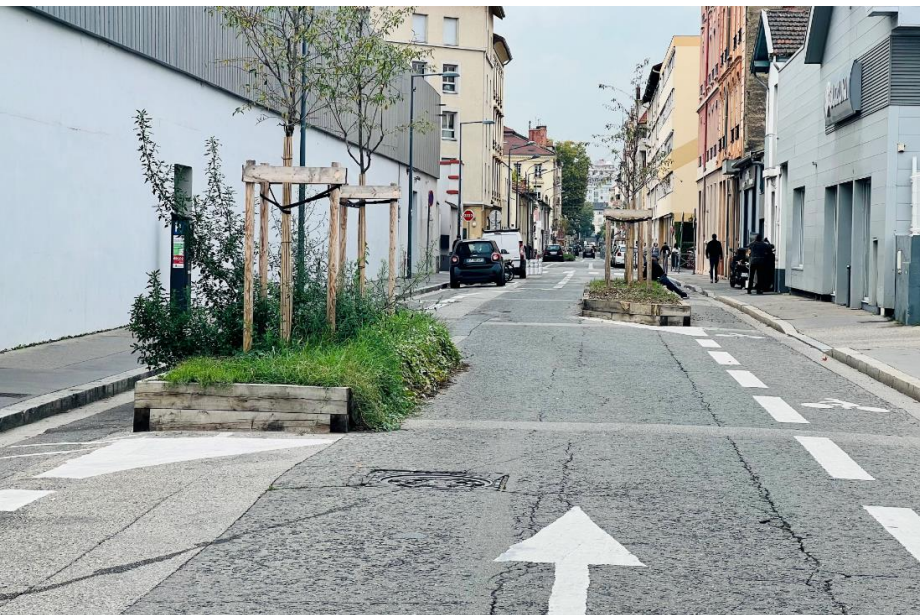
Ecluse avec massif végétalisé, intégrant un 'by-pass' vélo
