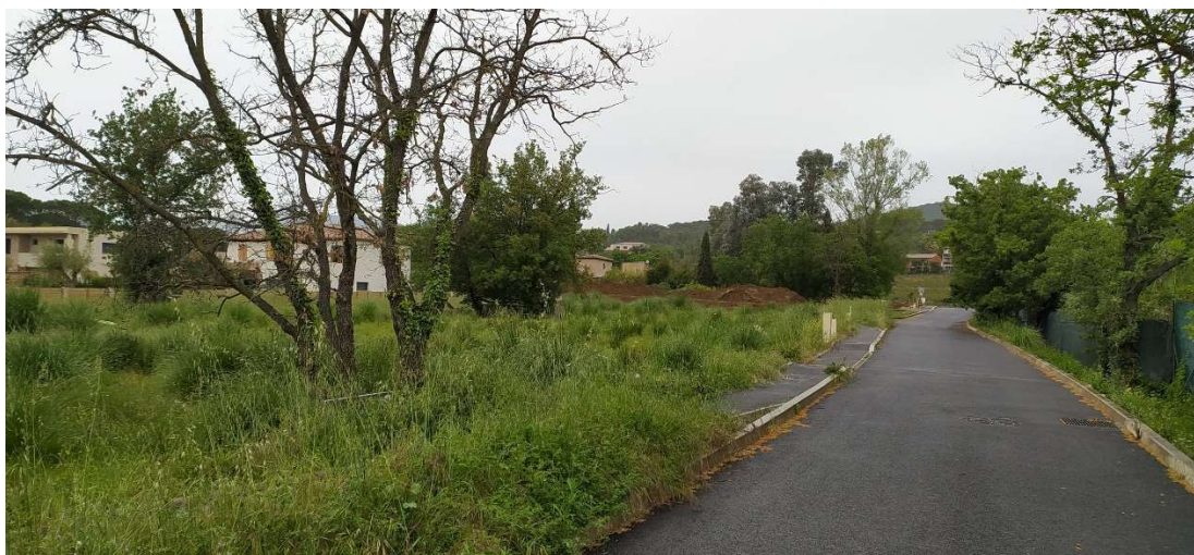
Figure 40: Site n°3 Les Vignaux accès parcelles viabilisées, Grimaud Crédit: Hélène Mayot © Cerema
