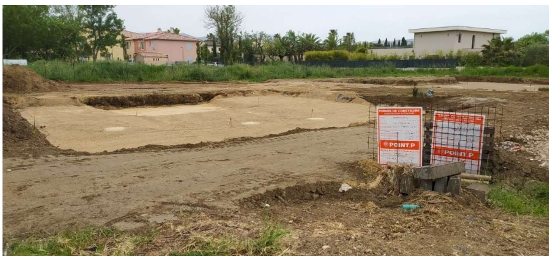
Figure 41: Site n°3 Les Vignaux parcelle en cours de construction, Grimaud Crédit: Hélène Mayot © Cerema
