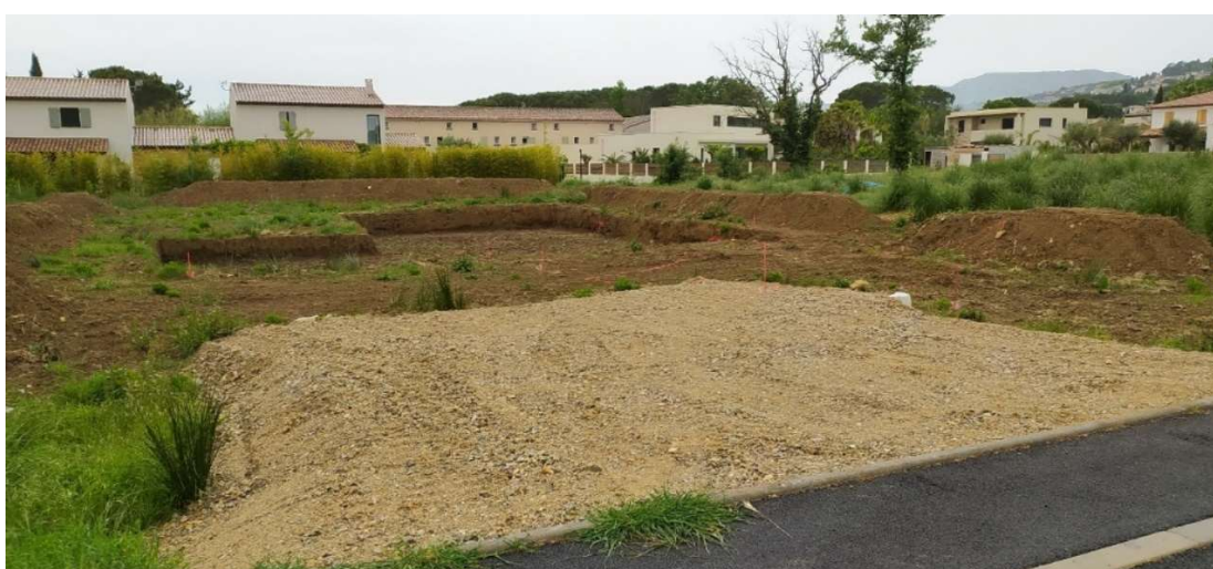
Figure 42: Site n°3 Les Vignaux parcelle en cours de construction, Grimaud Crédit: Hélène Mayot © Cerema
