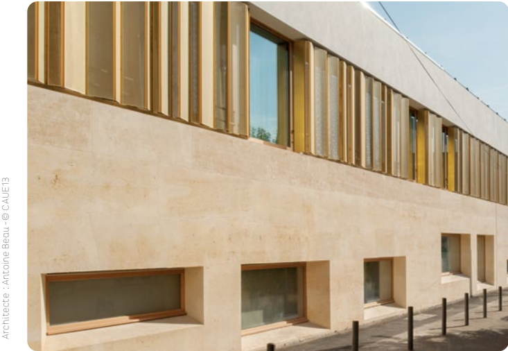
À l'étage, des volets pliables et, au rez-de-chaussée, des baies placées au nu intérieur d'un mur épais qui profitent de son ombre portée (école du Rouet, Marseille).
