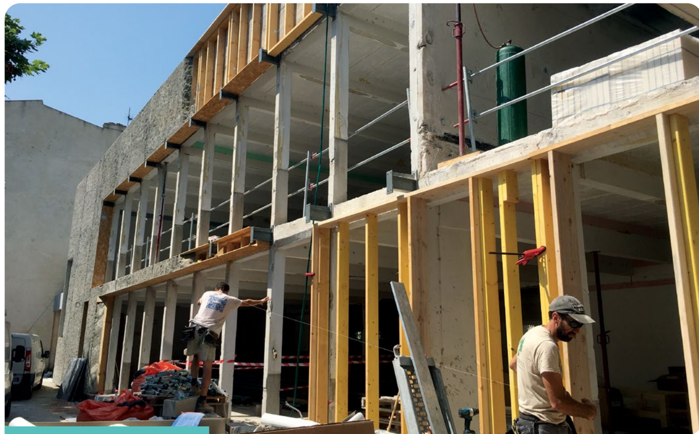
Pose de l'ossature bois avant remplissage. (École de la Roseraie, Marseille)
