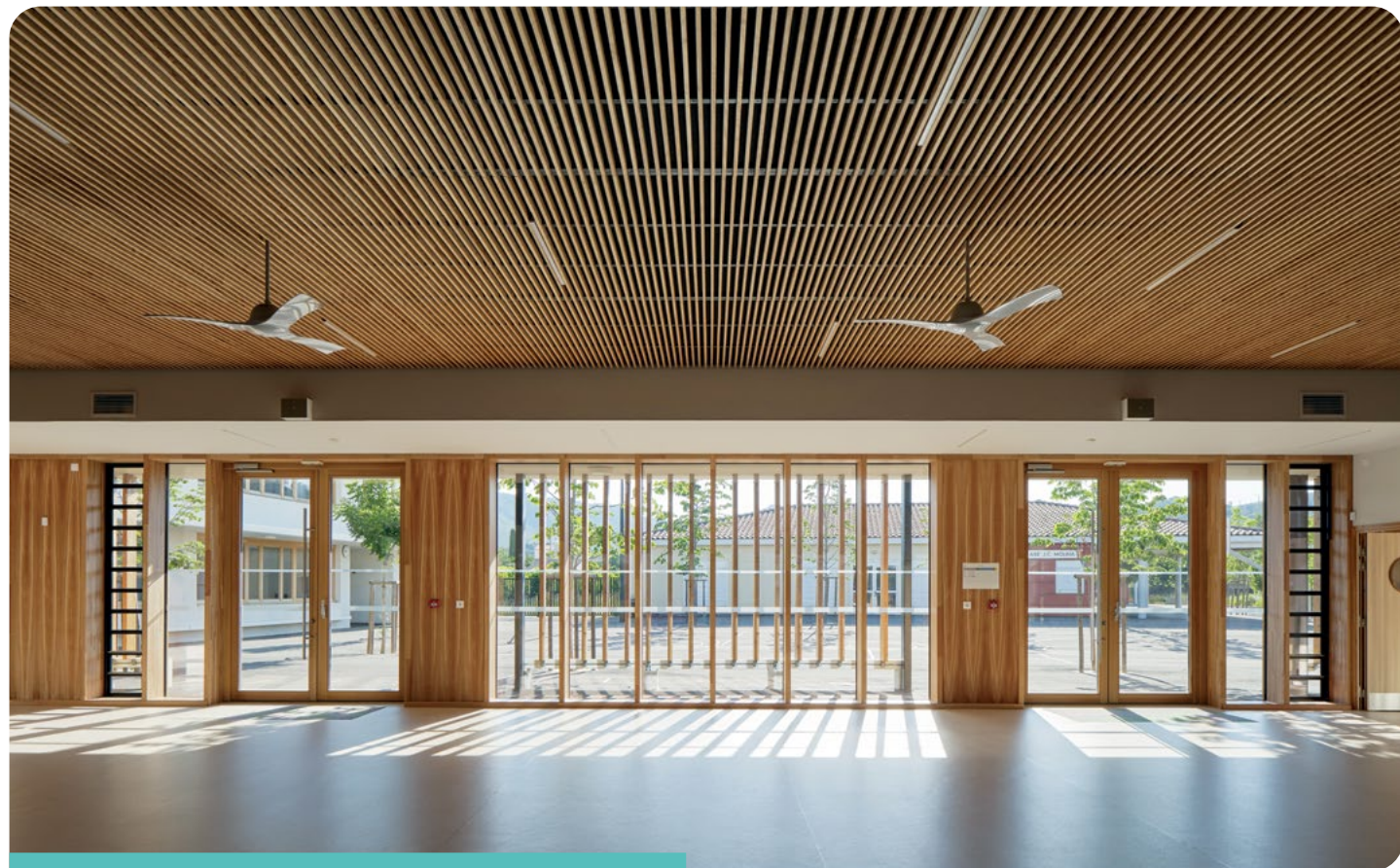
Les brasseurs d'air améliorent le confort d'été. (École Simone-Veil, Cuges les Pins)
