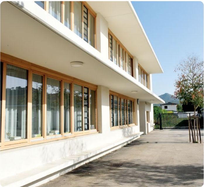
En novembre, la lumière extérieure n'est stoppée que partiellement par les casquettes et allèges. (École Simone-Veil, Cuges-les-Pins)
