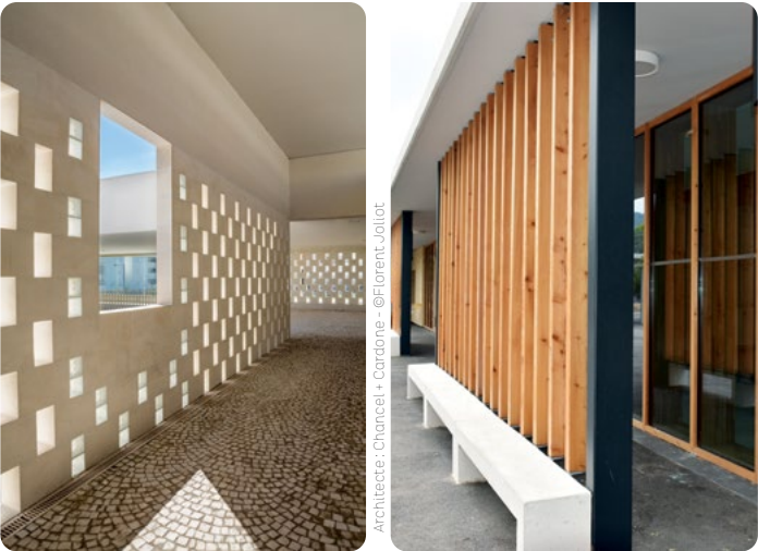
Un claustra en béton (école Paul-Cézanne, Miramas) ou des lames verticales fixes (école Simone-Veil, Cuges-les-Pins) protègent les baies vitrées de l'ensoleillement direct.
