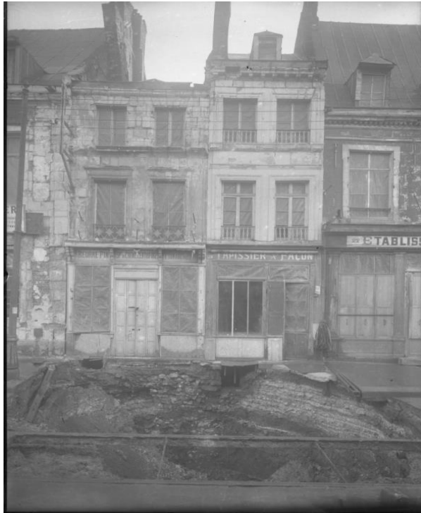
Effondrement Rue Raspail – 1930
