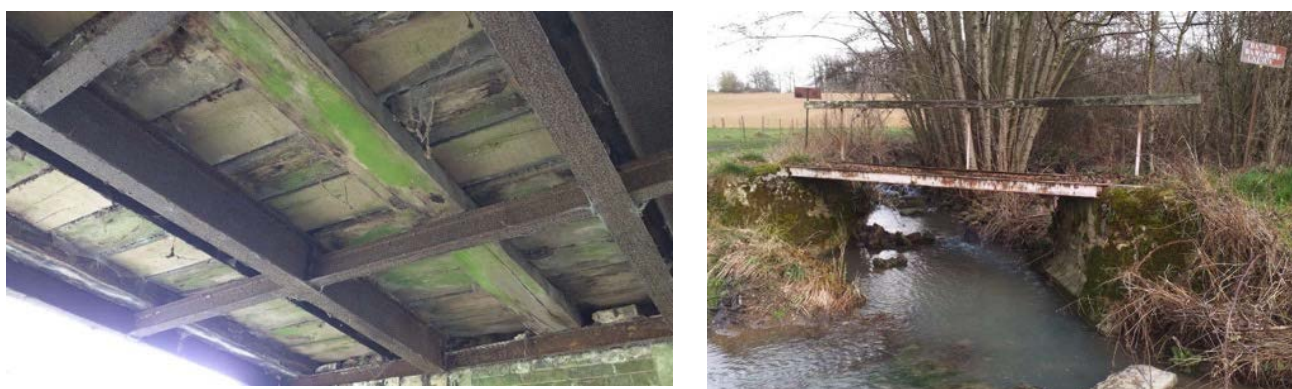
Figure 7 : Exemple d'ouvrages atypiques
