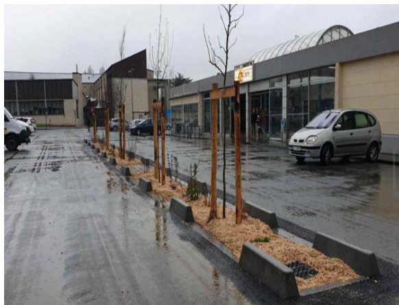
Déconnexion du réseau d'eau pluviale et de plantation sur une zone de stationnement, place Léon Jouhaux. / V. Pellerin
