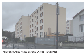
PHOTOGRAPHIE PRISE DEPUIS LA RUE - EXISTANT
