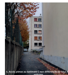
4. Accès piéton au bâtiment C non différencié de celui des voitures
