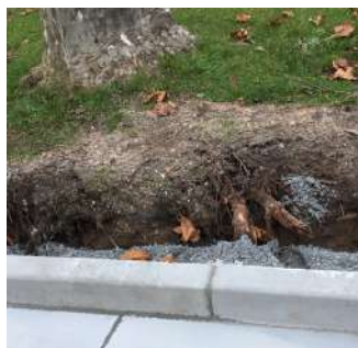
Racines sectionnées lors d'un chantier
