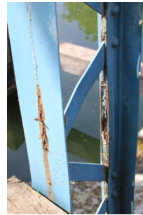
montant (secondaire repère 30) composé à treillis
