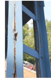
diagonale (repère 31) composée à traverses de liaison (échelle)
