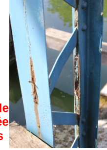
diagonale (repère 31) composée à traverses de liaison (échelle)
