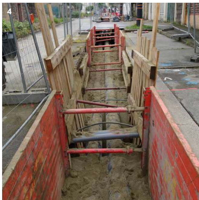
Pose d'un réseau de chaleur de diamètre total de 450 mm (200 mm de réseau + 250 mm de protection calorifuge) à Rennes, en 2022. / C. Courtant
