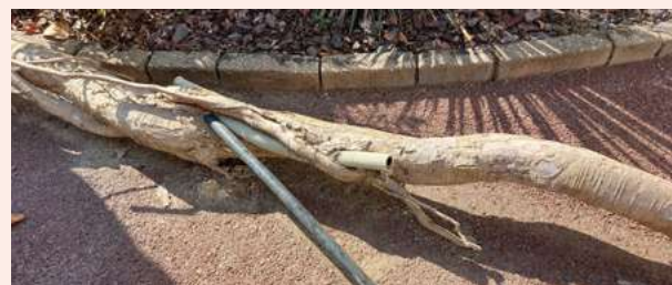
Canalisation de gaz enserrée dans une racine de platane à Nantes (2022). / F. Freytet
