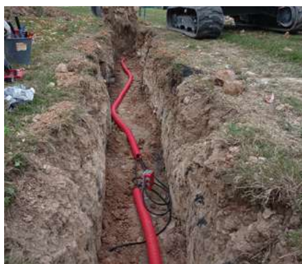
Pose d'un déversoir dans la commune de Le Coudray pour protéger un ouvrage de transport de gaz (hors champ). Le dispositif est constitué d'anodes posées à l'horizontale. Les fourreaux rouges contiennent les câbles de connexion. / GRDF
