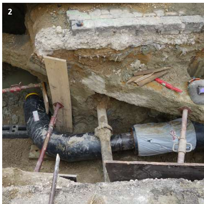
Pose d'un réseau de chaleur de diamètre total de 450 mm (200 mm de réseau + 250 mm de protection calorifuge) à Rennes, en 2022. / C. Courtant
